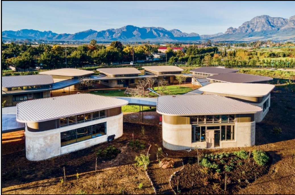
FIGUUR 8a: Fabio Venturi (Terramanzi Group), Green School South Africa (Groen Skool Suid-Afrika) (GSSA) , Paarl (Wes-Kaap), beton en herwinde materiale, 2022.
